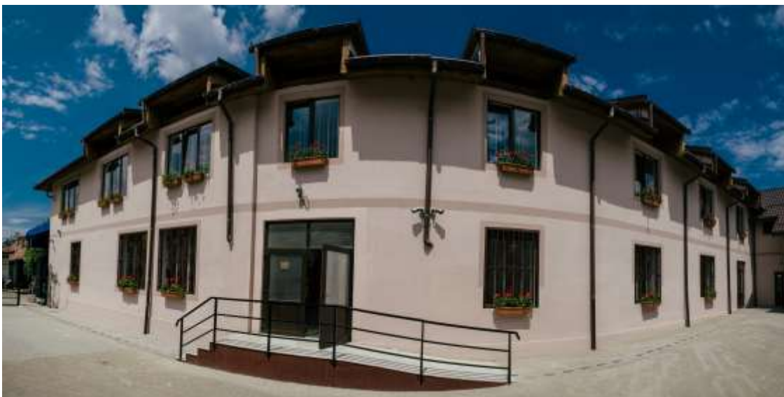
Foto captură proprie – Sediul nou al Primăriei Hârseni
